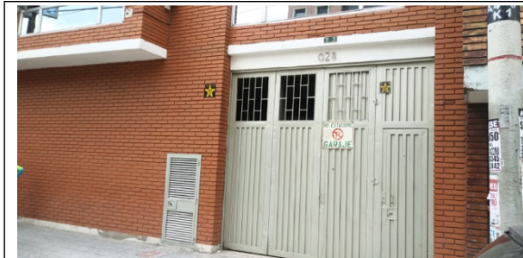
FOTO N. 1 FACHADA DEL PREDIO.
