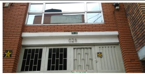
FOTO N. 2 NOMENCLATURA DEL PREDIO.
